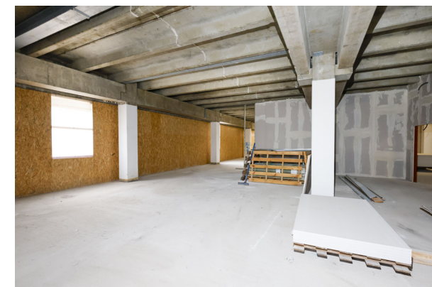
Innenausbau im Erdgeschoss
